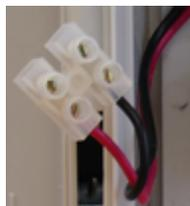
Рисунок 12. Клеммы для подключения замка к блоку питания
